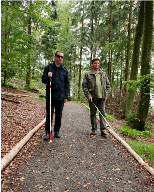
Abbildung 21: Taktile Leitkanten aus Rundhölzern im Nationalpark Eifel, hier auf einer abschüssigen Strecke, auf der erhöhte Aufmerksamkeit gefordert ist. (Quelle: U. Giesen)
