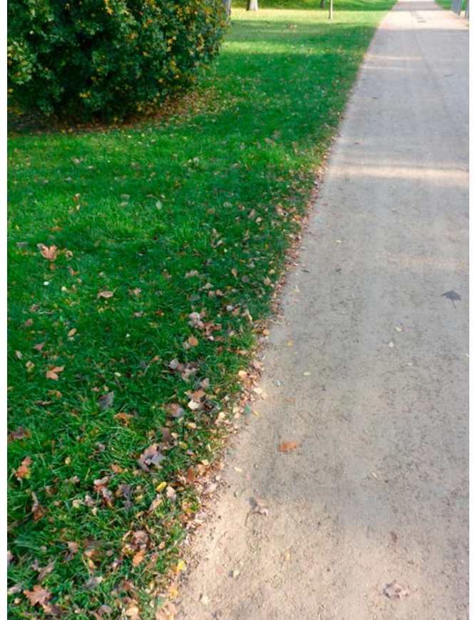
Abbildung 3: Kontrastreiche Leitlinie zwischen Weg und Rasenfläche (Quelle: Sweco GmbH)
